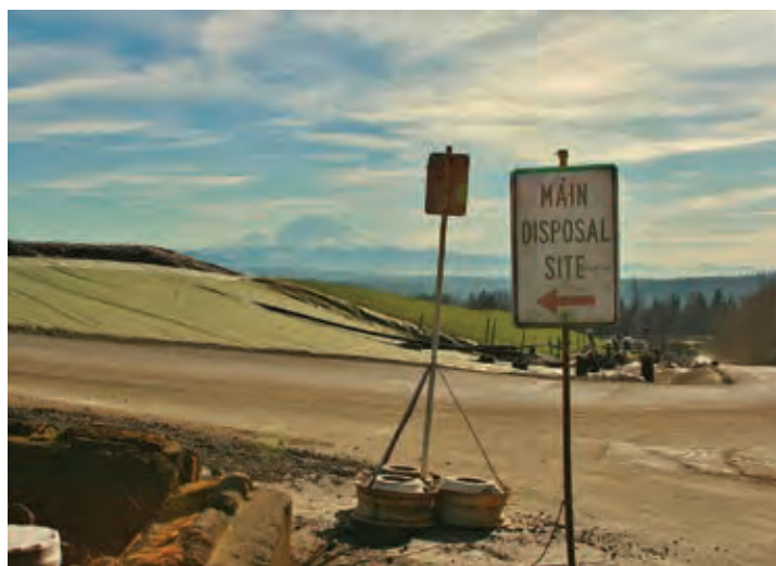
Cedar Hills Regional Landfill
